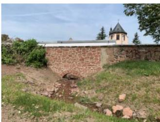
Durch einen neu gestalteten Mauerdurchlass wird der Bach in das Gelände des Klosterparks geführt.
