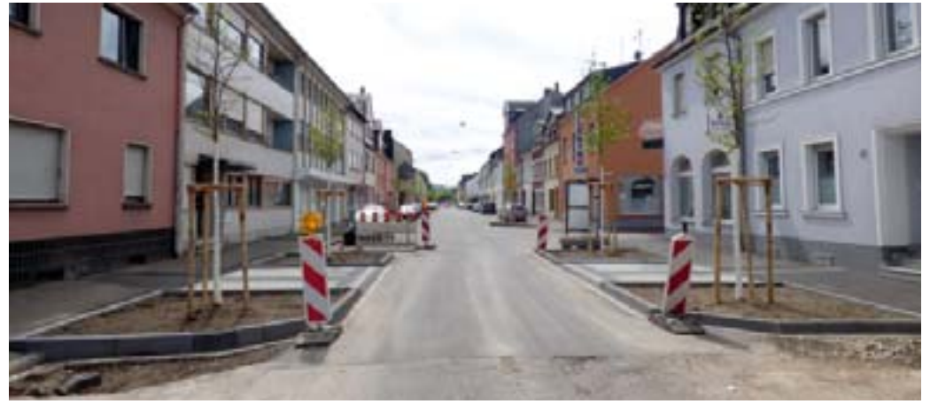
Der Blick in den fertiggestellten ersten Bauabschnitt zeigt, wie sich die Karthäuser Straße nach der Baumaßnahme präsentieren wird.
