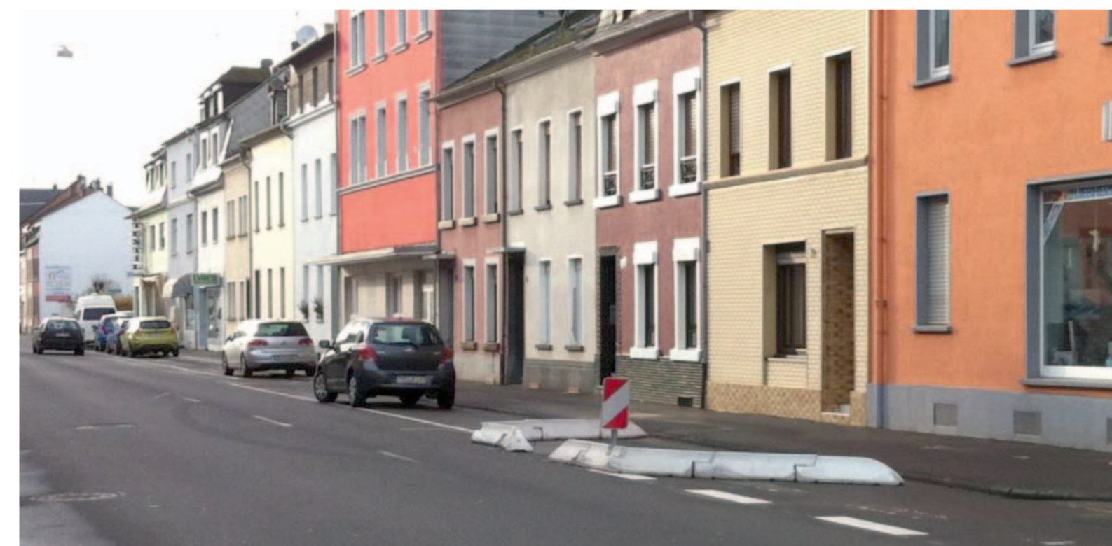
Die bisher noch als Provisorium errichteten Fahrbahnverengungen werden schon bald baulich umgesetzt.
